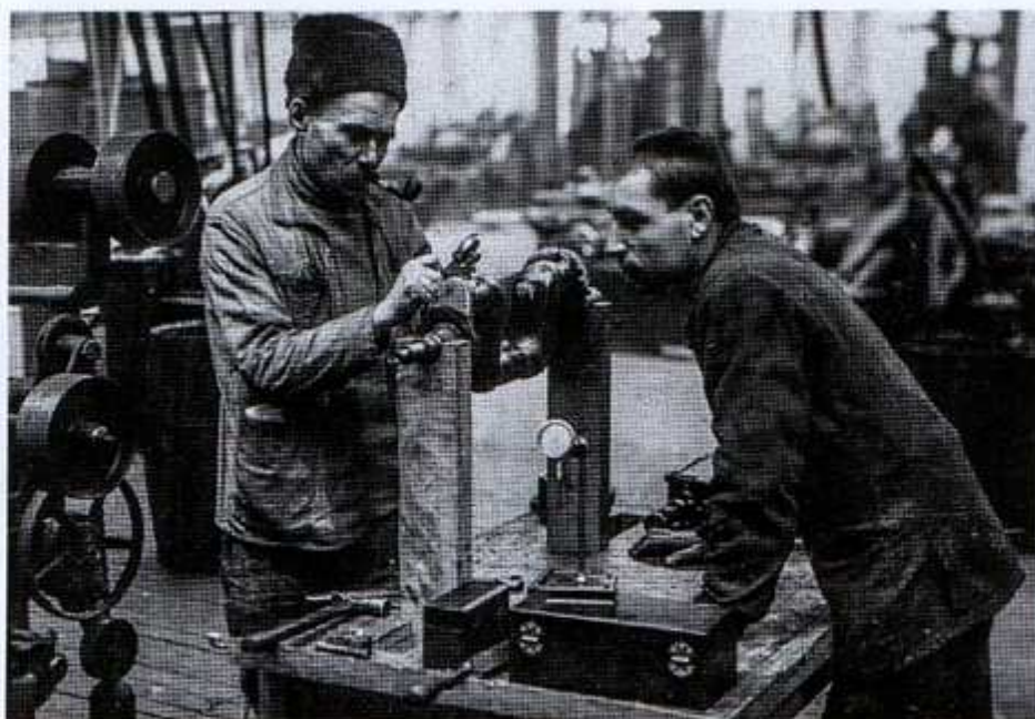
Проверка размеров коленчатого вала автомобильного двигателя
