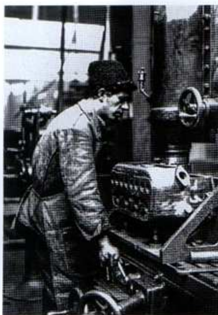
Обработка блока цилиндров
