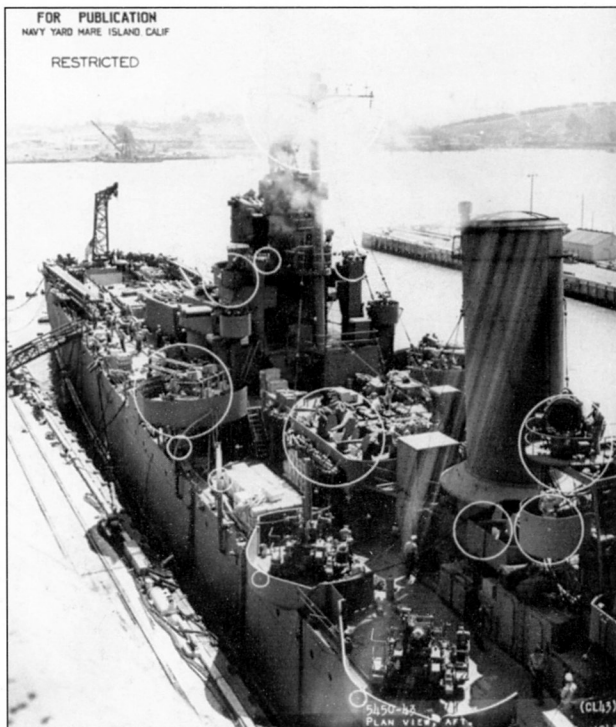
Вверху и внизу: «Нэшвилл» на верфи «Мэйр Айленд», 30 июля 1943 года. В ходе модернизации была уменьшена высота носовой надстройки, на КДП Mk.34 РЛС управления огнем Mk.3 заменена на более совершенную Mk.8. На фок-мачте хорошо видна антенна РЛС SK.
