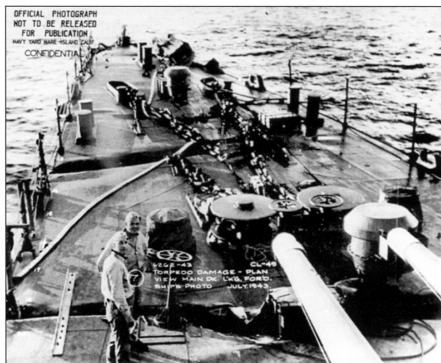
На трех снимках сверху: повреждения носовой оконечности «Сент-Луи», полученные во время боя у Коломбангара. На нижнем снимке хорошо видны гофры, образовавшиеся на палубе бака
