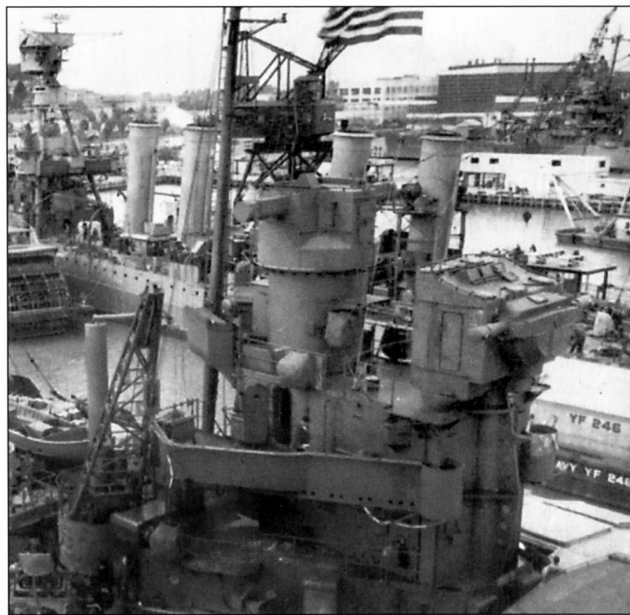
Приборы управления огнем крейсера «Гонолулу». Командно-дальномерные посты главного (Mk.34) и зенитного (Mk.33) калибров на носовой (слева) и кормовой (справа) надстройках. Снимки сделаны на верфи «Мэйр Айленд» в январе 1942 года в ходе ремонта, когда на носовом КДП главного калибра была смонтирована антенна РЛС управления огнем Mk.3
