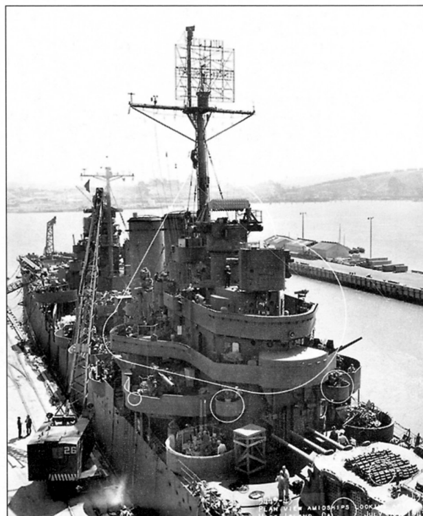
Вверху и внизу: «Нэшвилл» на верфи «Мэйр Айленд», 30 июля 1943 года. В ходе модернизации была уменьшена высота носовой надстройки, на КДП Mk.34 РЛС управления огнем Mk.3 заменена на более совершенную Mk.8. На фок-мачте хорошо видна антенна РЛС SK.
