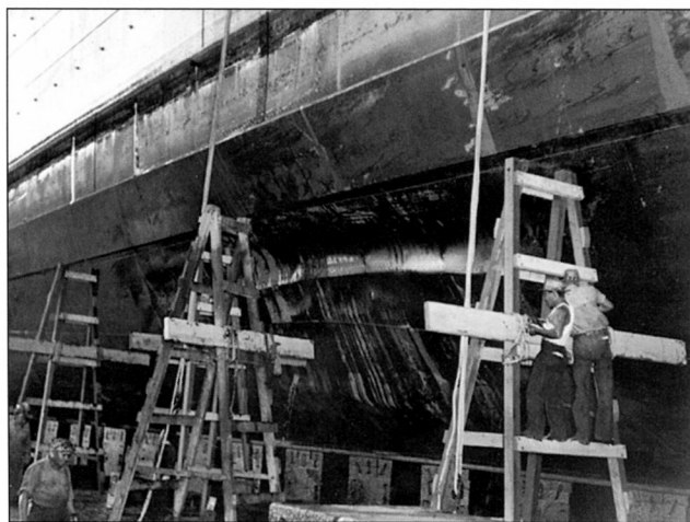
Повреждения корпуса «Гонолулу» от близкого разрыва бомбы во время налета японской авиации на Перл-Харбор. Снимок сделан 13 декабря
