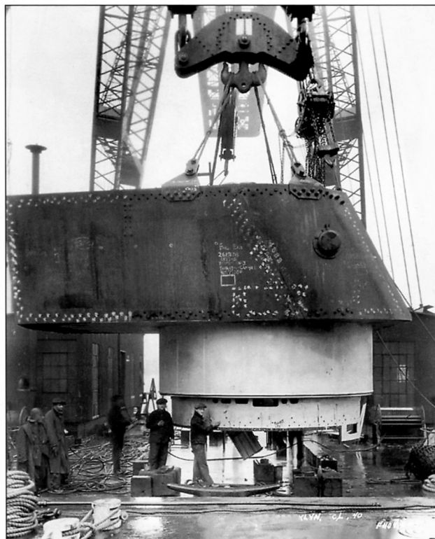
Монтаж башни главного калибра на крейсер «Бруклин», 11 декабря 1936 года
