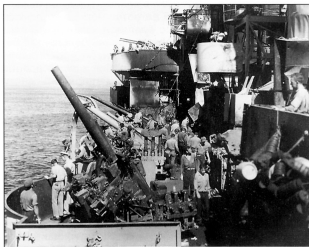
Повреждения, вызванные попаданием «камикадзе» в зенитную батарею «Нэшвилла» 13 декабря 1944 г.
