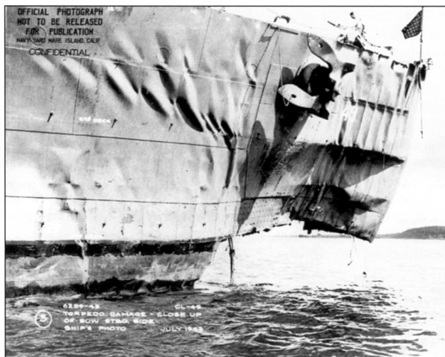
Пробоина от невзорвавшейся торпеды в корме «Гонолулу». Тулаги, 13 ибля 1943 г.
