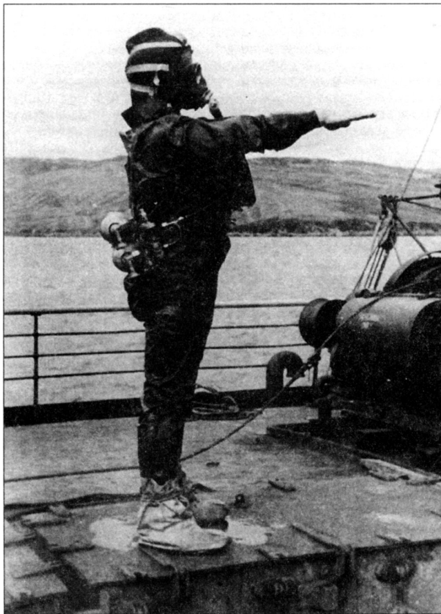
Вверху и слева: водолазный костюм Слейдена первой модификации (Mark I). Фотографии облаченного в костюм лейтенанта Джеффри Ларкина сделаны на борту плавбазы «Титания», Лох-Кейрнбоун, Шотландия
