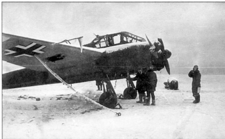
Захваченный Красной армией Fw 189A. Самолет «пришвартован» к вбитым в землю кольям с проушинами, чтобы его не сносило ветром
