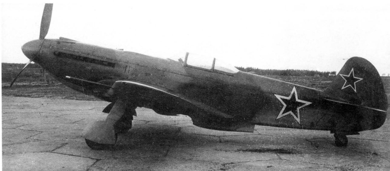
Внизу: головной серийный Як-9У с двигателем ВК-107А (заводской № 25-021, построен в Омске в апреле 1944 г. и собран на заводе № 301 в мае 1944 г.). Государственные испытания. Август 1944 г.
