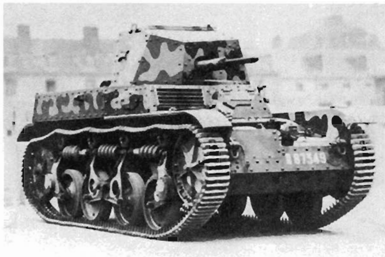
Легкий танк AMR 35ZT, вооруженный 13,2-мм пулеметом.
