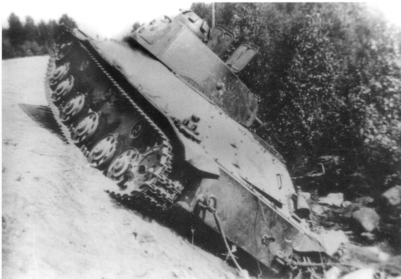
Еще одно фото танка Т-50, потерянного в районе Петрозаводска. Июль-август 1941 года. Судя по положению машины, при выезде на дорожную насыпь у нее мог заглохнуть двигатель. На снимке хорошо видна укладка домкрата и запасных траков. Буксирные тросы свидетельствуют о том, что танк пытались буксировать (фото из архива Е. Муикку).
