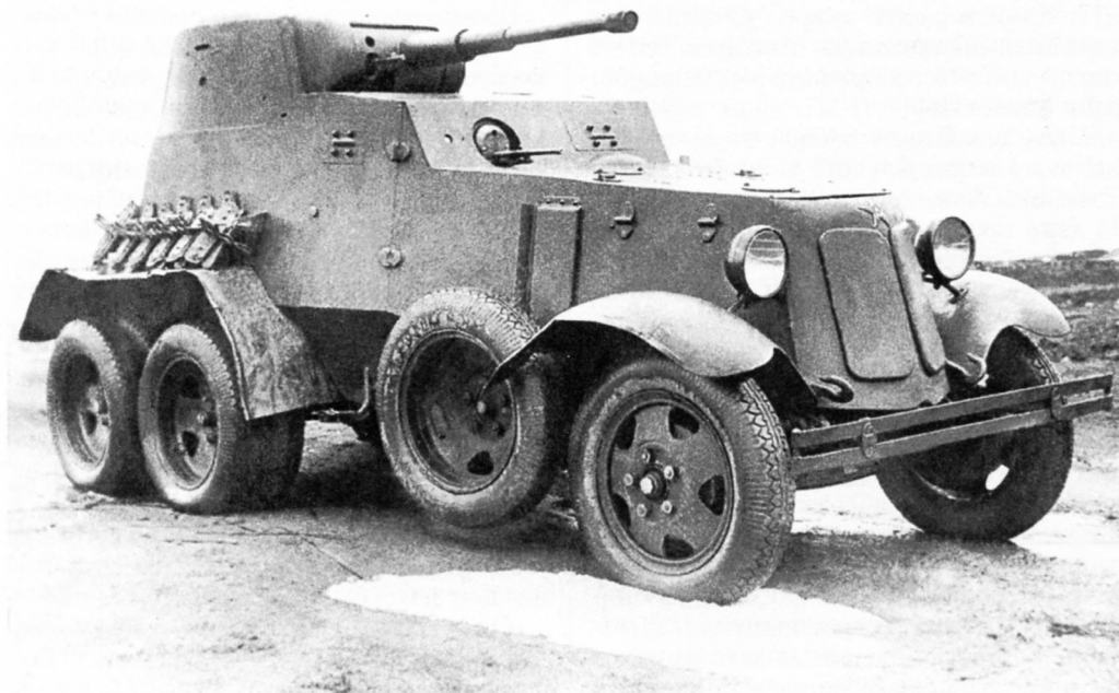
Бронеавтомобиль БА-6 м. Осень 1936 года. Двери и люки моторного отделения установлены на наружных петлях (АСКМ).
