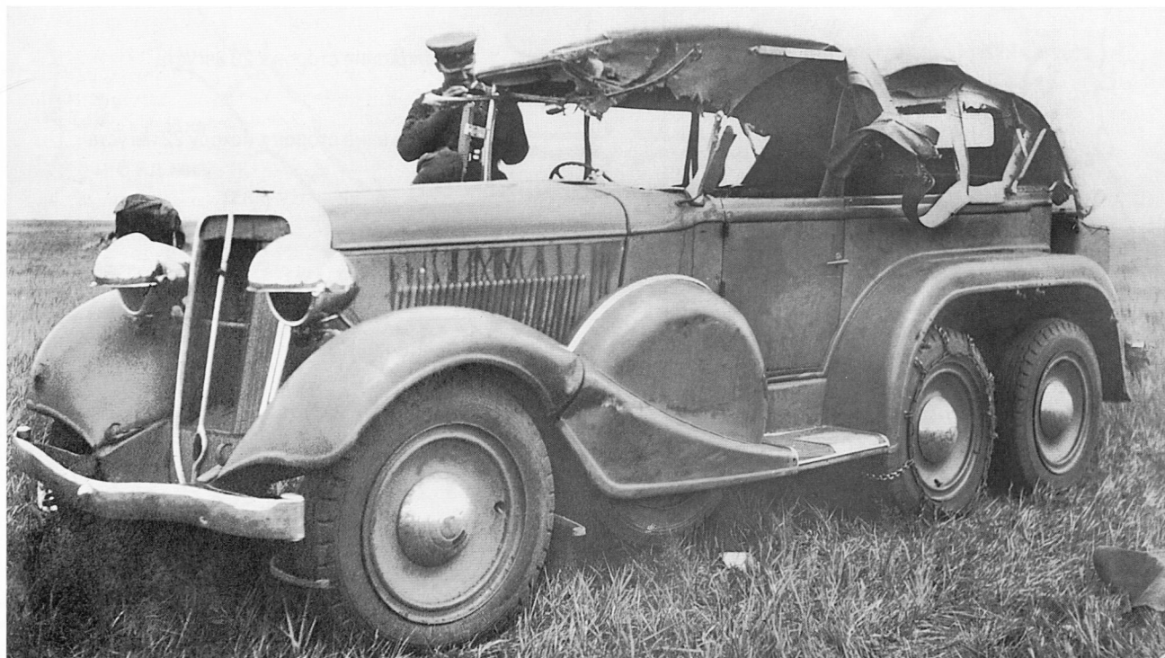
Трофейный японский штабной автомобиль Тип 96 (заводское обозначение Isuzu K10). Август 1939 года. Обратите внимание на цепь для улучшения проходимости, надетую на среднее колесо (АСКМ).
