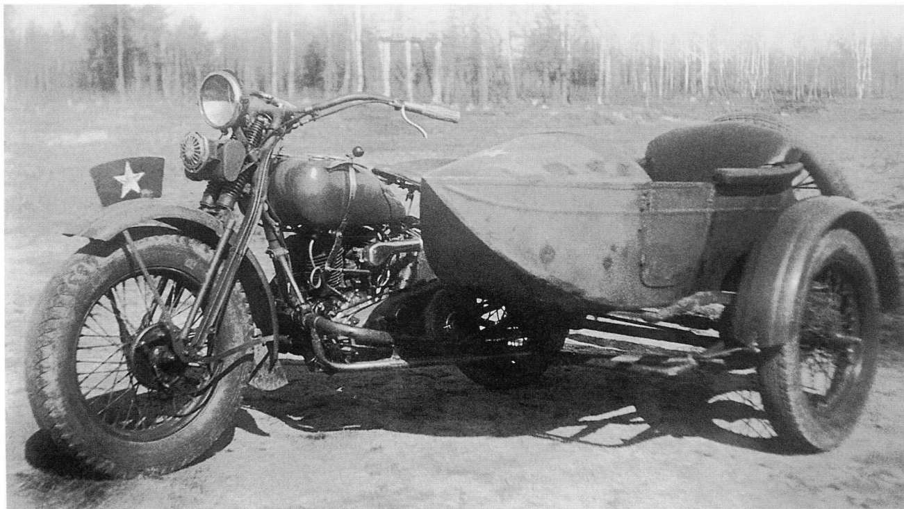
Трофейный японский мотоцикл Тип 97 (с приводом на колесо коляски) во время испытаний на НИБТ полигоне в подмосковной Кубинке, осень 1939 года. Мотоцикл был захвачен в ходе боев на Халхин-Голе (РГВА).
