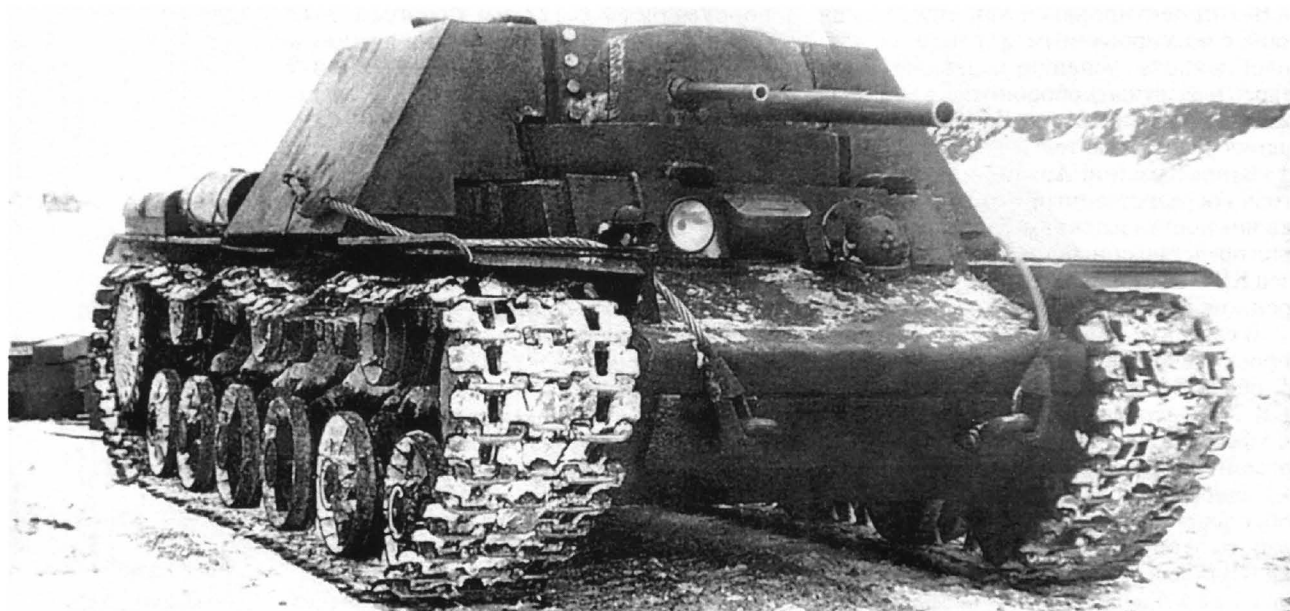
Первый вариант танка КВ-7 (с двумя 45-мм и одной 76-мм пушками) во время испытаний на полигоне. Зима 1942 года. (с. 60 и с. 61 вверху)
