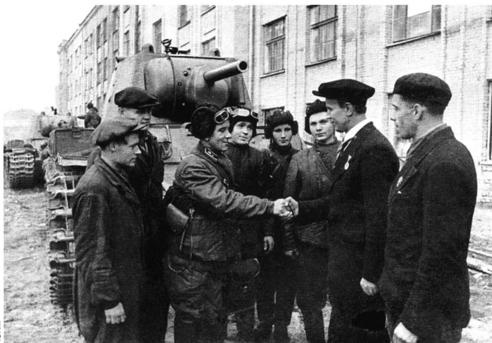
Последние приготовления перед передачей танка КВ-1 представителям Красной Армии. Ленинград, сентябрь 1941 года. На надгусеничных полках установлены дополнительные топливные баки.
