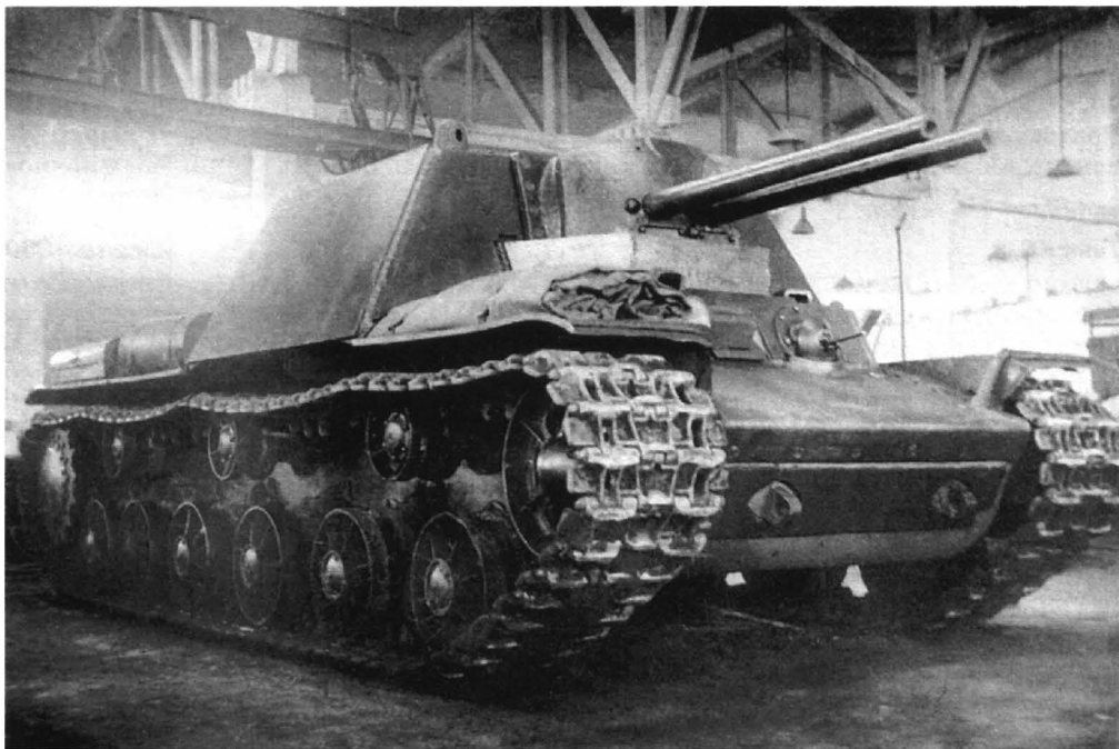
Второй вариант танка KV-6 (с двумя 76-мм орудиями) в цехе завода № 100. Челябинск, май 1942 года.
