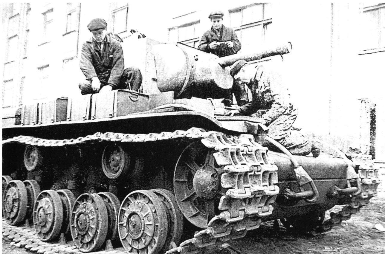
Последние приготовления перед передачей танка КВ-1 представителям Красной Армии. Ленинград, сентябрь 1941 года. На надгусеничных полках установлены дополнительные топливные баки.
