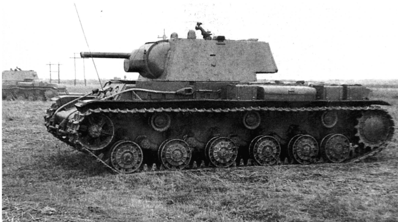
Танки КВ-1 выпуска августа—октября 1941 года (с упрощенной башней и усиленными катками). Ленинградский фронт, октябрь 1941 года.
