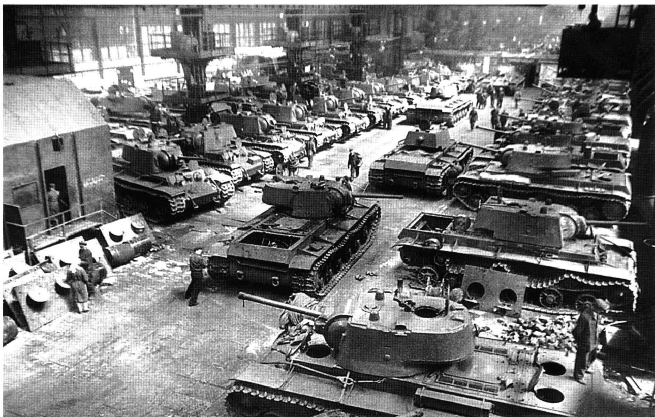
Цех сборки танков Челябинского Кировского завода, весна 1942 года. Хорошо видно, что часть танков оснащена литыми, а часть сварными башнями.
