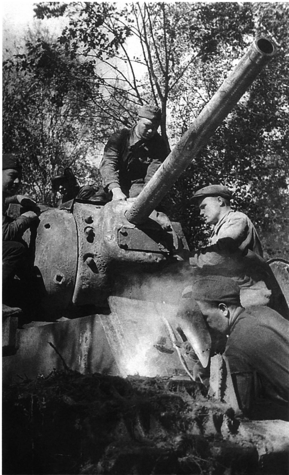
Ремонт танка КВ-1 в полевых условиях. Волховский фронт, 124-я танковая бригада, август 1942 года.
