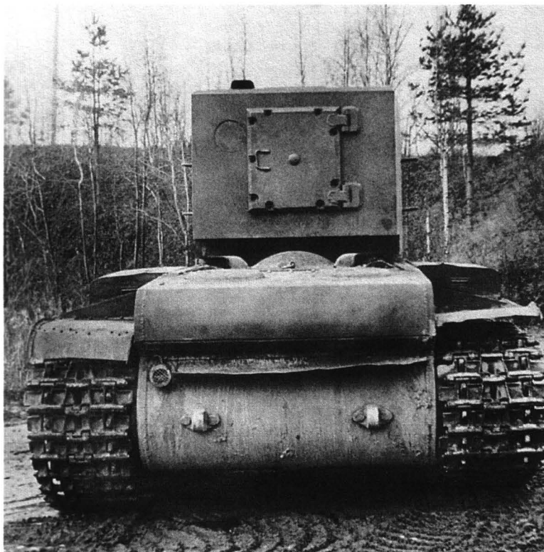
Танк У-7 с установленным на нем первым образцом «пониженной» башни для 152-мм гаубицы перед прохождением испытаний. Сентябрь 1940 года.
