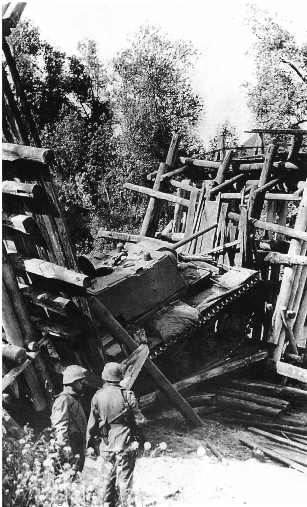
Этот снимок хорошо демонстрирует проблемы, возникающие из-за высокой массы танков КВ-1 при их эксплуатации: немецкие солдаты осматривают танк (с литой башней), провалившийся при движении по мосту. Лето 1942 года.
