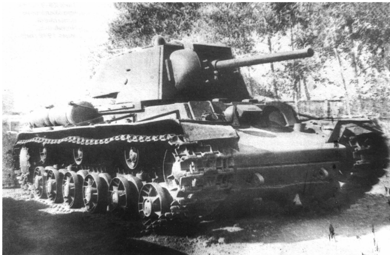
Химический танк КВ-12 (объект 232). Челябинск, завод № 100, весна 1942 года. Хорошо видны резервуары для химических веществ, установленные на бортах танка.
