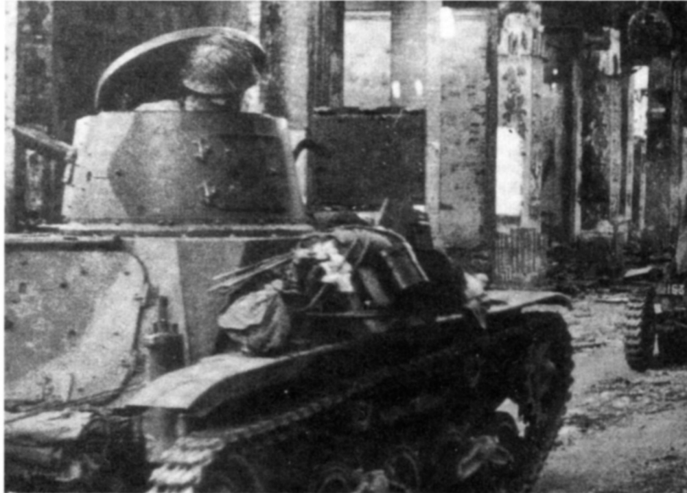
Малые танки Тип 94 ИК с модифицированной ходовой частью
