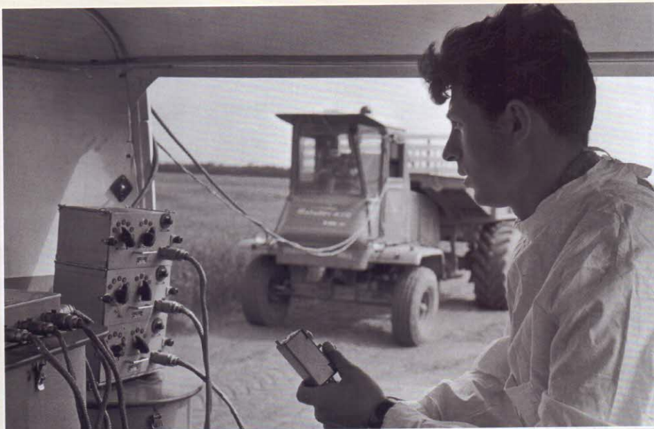
Испытания самоходного шасси СШ-75 с помощью передвижной тензометрической лаборатории на силу вибрации в кабине водителя. 1968 г.
