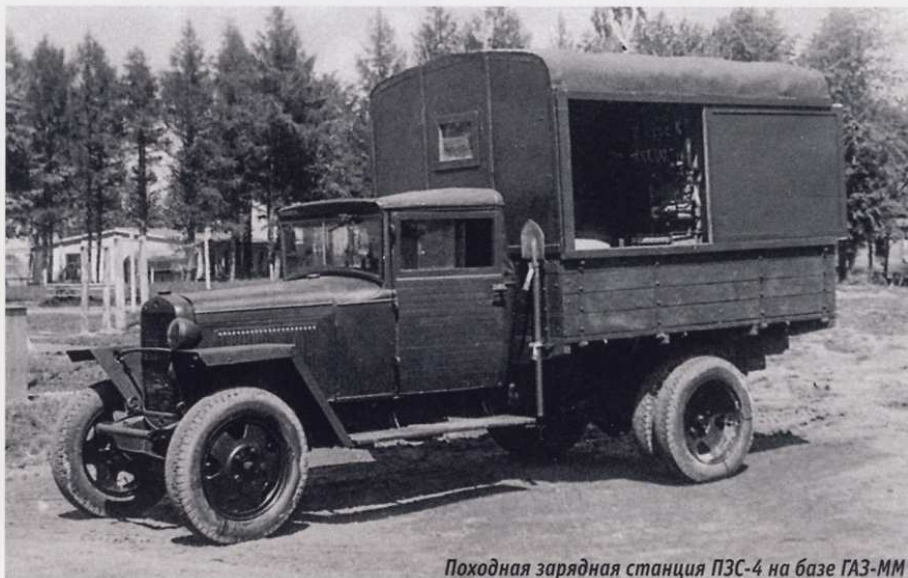
Походная зарядная станция ПЗС-4 на базе ГАЗ-ММ
