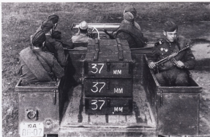
Размещение личного состава и боеприпасов на платформе ГАЗ-68 (образец №3)
