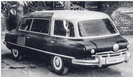
Первый полноразмерный макет автомобиля НАМИ-013 отличался всего одной фарой, установленной по центру передка
