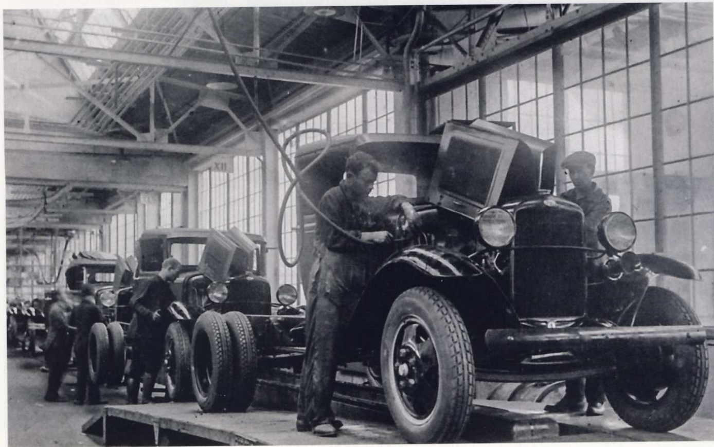
Сборка грузовиков Ford AA в Москве
