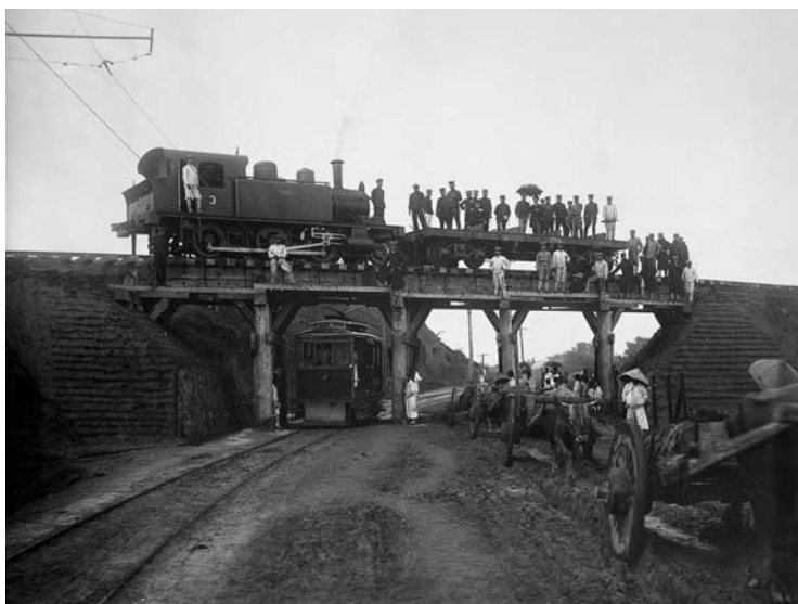
Новые времена требуют новых знаний и новых технологий: строительство железнодорожного путепровода над трамвайной линией в Сеуле, 1904 год
