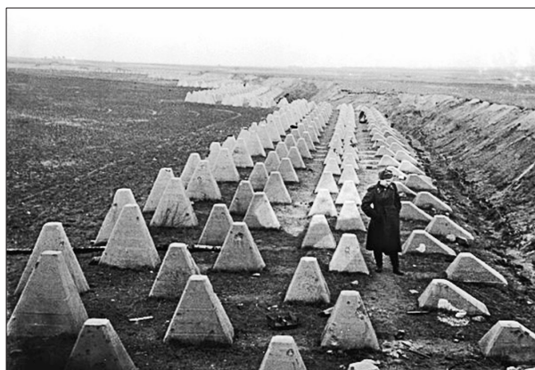
Рис. 7.22. Противотанковые надолбы: а — схема пятирядной линии; б — общий вид
