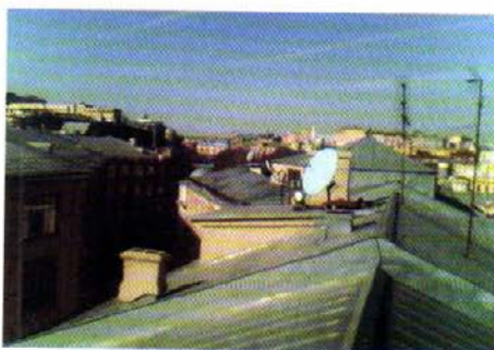
Рис. Ц-45. Стальную кровлю покрывают цинком, чтобы она не ржавела
