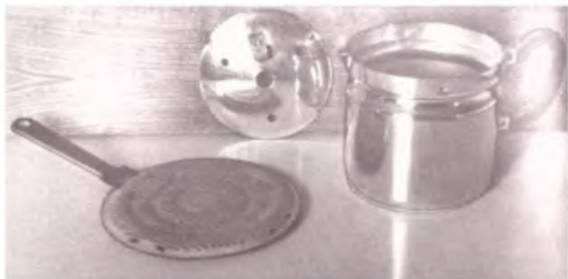
Приспособление для газовой плиты («рассекатель» пламени) и молоковарка со «сторожем»
