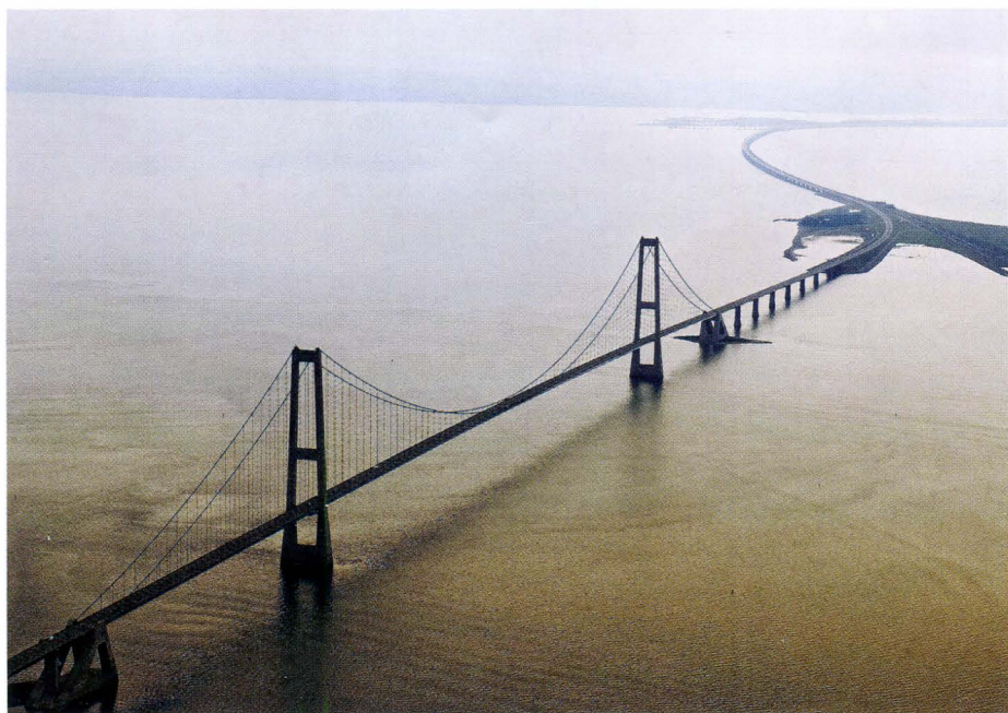
Восточный участок моста «Большой Бельт», соединяющего датские острова Зеландия и Фюн, с пролетом длиной 1624 м и 280-метровыми пилонами.
