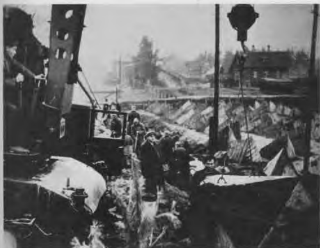
◀ 16 сентября 1941 года. Строительство укреплений вокруг Ленинграда. На снимке: автокран монтирует линию надолб
