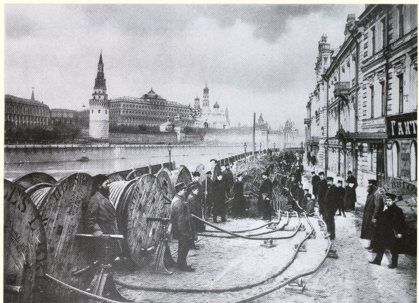
Укладка электрического кабеля для трамвая
