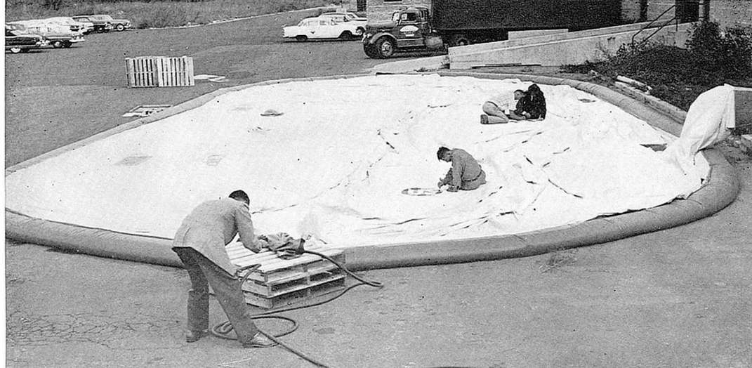
Насос (справа) нагнетает воздух в здание и поддерживает в нем постоянное давление.
