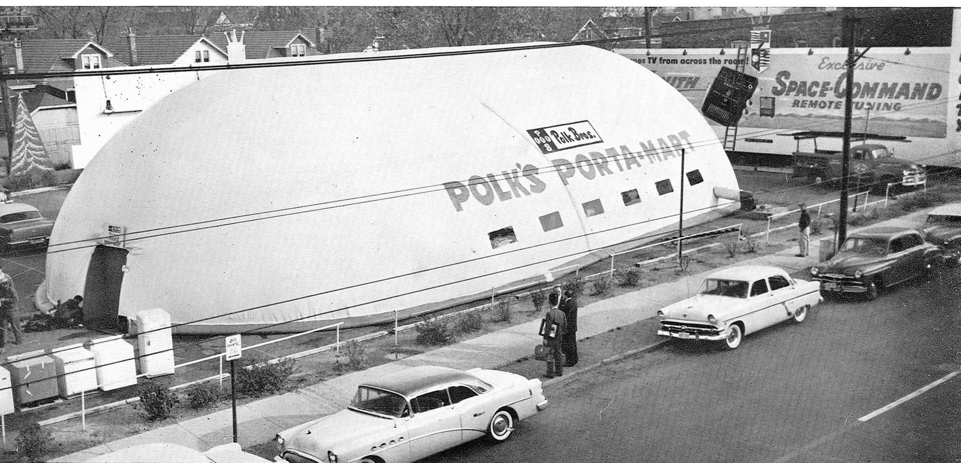
НАГНЕТАНИЕ ВОЗДУХА ПРОДОЛЖАЕТСЯ НЕ БОЛЬШЕ ЧАСА, НО ЗДАНИЕ-БАЛЛОН МОЖЕТ ПРОСТОЯТЬ ОКОЛО ШЕСТИ ЛЕТ. ВЕС ЕГО НЕ ПРЕВЫШАЕТ 220 КГ.
