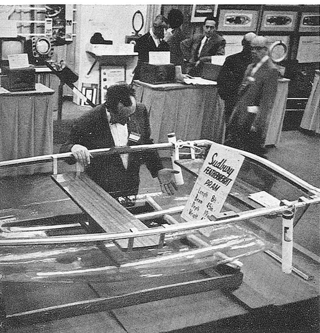
ПРОЗРАЧНАЯ ЛОДКА из пластмассы вмещает троих пассажиров и весит лишь 20 килограммов. Ее продажная цена — 200 долларов (800 рублей).
