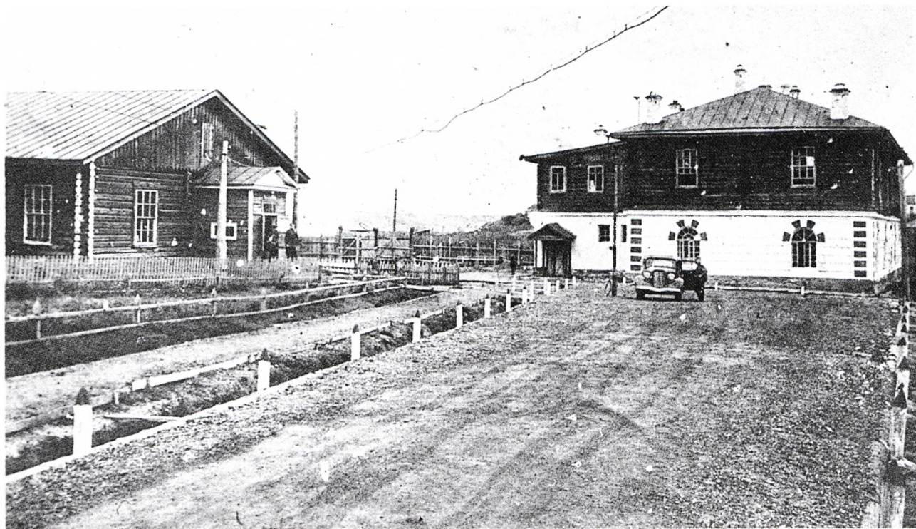
№ 59. Каменная мостовая на шлаковом основании на территории Киевского танкотехнического училища. Вид летом. г. Кунгур, Молотовская область. 1943 г. КГА. Ф. 477. Оп. 1. Д. 289. Л. 406.
