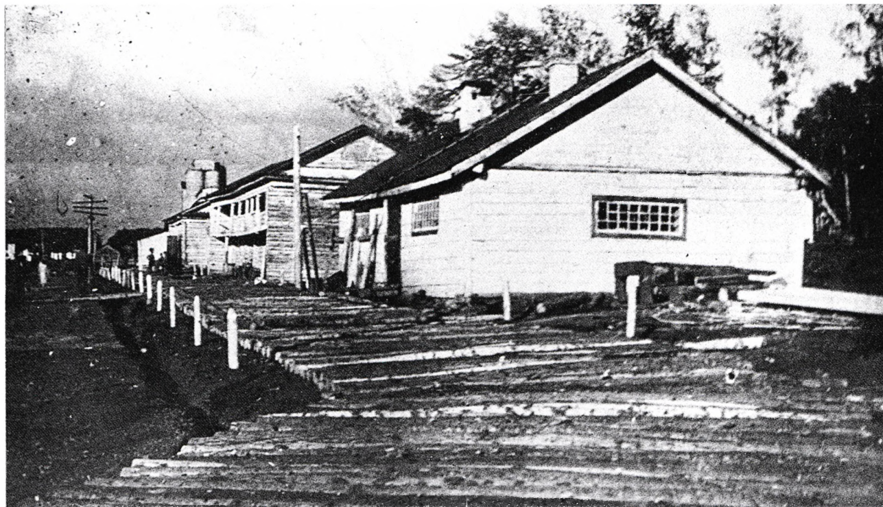
№ 60. Строящаяся бревенчатая дорога на шлаковом основании на территории Киевского танко-технического училища. г. Кунгур, Молотовская область. 1943 г. КГА. Ф.477. Оп. 1. Д. 289. Л. 506.
